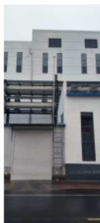
投料除尘风机+排气筒
