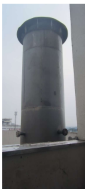
水膜除尘+干燥废气排气筒
